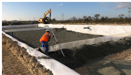
La station d'épuration
